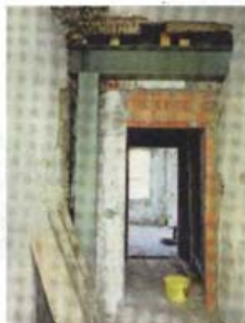
Stahlträger stützen das Haus an sehr maroden Stellen.
