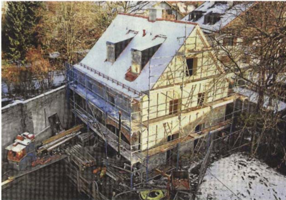
Unscheinbares Kleinod: Das Neusöonner Schlösschen ist derzeit vom Dachstuhl bis zum Keller Baustelle.
