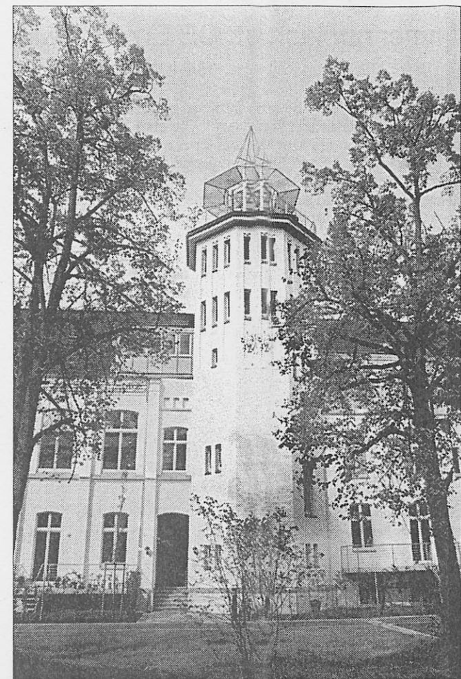
Der Kirchturm als Dachterrasse. Brandstiftern war das Gebäude mehrfach zum Opfer gefallen. Jetzt ist aus dem Kirchturm (ein Stahlgerüst) eine Wohnung geworden.
